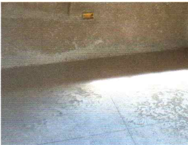
Foto 3 - Visão interna do PSF Campo de Buraco detalhe do piso em granilite em execução
