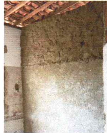
Foto 2 - Visão interna do PSF Campo de Buraco complemento da alvenaria e emboçamento
