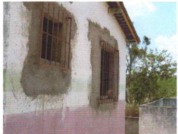
Foto 4 - Visão externa do PSF Campo de Buraco detalhe das grades das janelas colocadas
