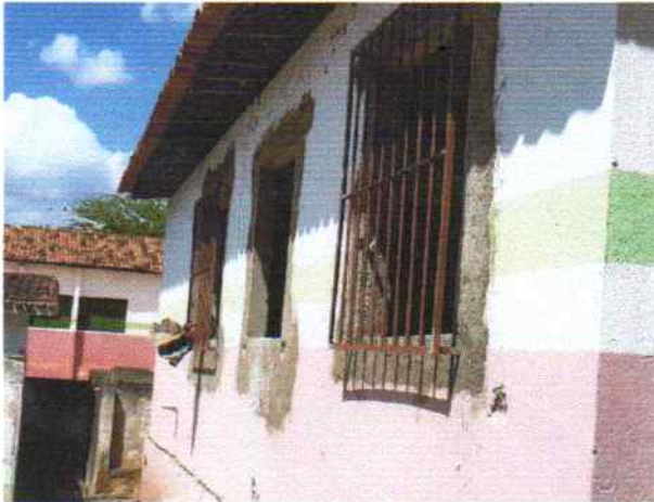
Foto 1 - Visão externa do PSF Campo de Buraco colocação das grades das janelas
